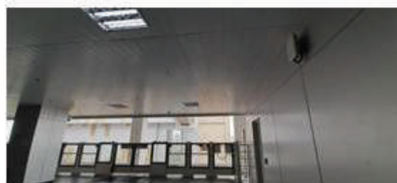
Antenna Wi-Fi yang terpasang di Stasiun
